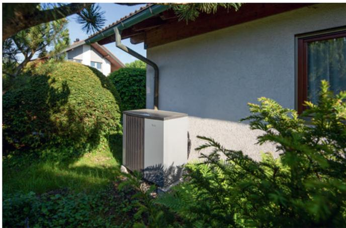
Die Schallemissionen sind in jeder Planung eine wichtige Grösse. Eine Wärmepumpe mit Aussenluft verursacht Geräusche. Die meisten Geräte mit zeitgemässer Technik arbeiten leise. Für solche neu installierten Wärmepumpen ist ein Lärmschutznachweis erforderlich. Er zeigt, dass die gesetzlichen Vorgaben, gemessen an dem Fenster eines lärmempfindlichen Raums mit der kürzesten Distanz zur Lärmquelle, eingehalten sind.
