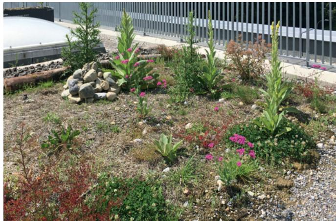
Wie ein Schwamm nimmt die Vegetationstragschicht das Regenwasser auf begrünten Flachdächern auf. Dieser Speicher ermöglicht das Wachstum der Pflanzen, die wiederum zur Hitzeunterdrückung in der Umgebung und im Gebäude beitragen.
