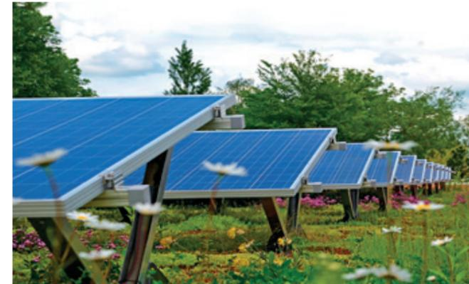
Achten Sie darauf, dass die PV-Module genügend Abstand zur Vegetationstragschicht haben. Mit einer Aufständigung von etwa 30 cm erhalten die Pflanzen ausreichend Raum zum Wachsen. Die Aufständigung stellt sicher, dass die Pflanzen die PV-Module nicht verschatten und Sie keine Ertragsverluste hinnehmen müssen. Verschiedene Hersteller bieten Aufständigungen für PV-Module an. So ist eine qualitativ hochwertige extensive Dachbegrünung möglich.
