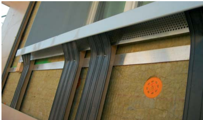
seitliche Leibungsdämmung
