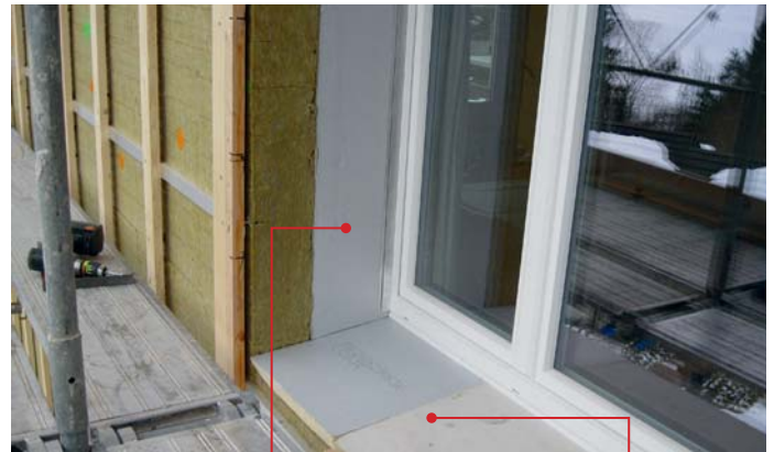
seitliche Leibungsdämmung
