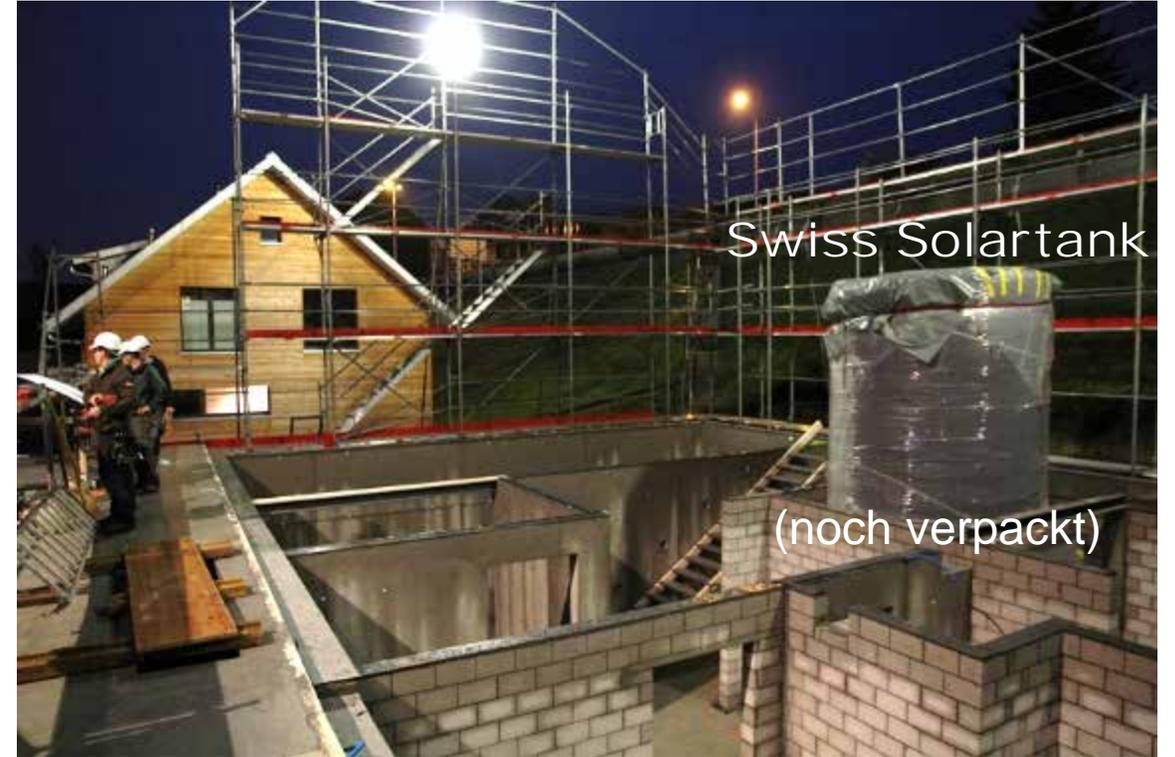
Herzstück: Swiss Solartank mit integriertem Boiler Höhe 5'380mm, Ø 2'000mm, Inhalt 15'300l
