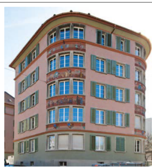
Gebäudetyp 2, Nr. 1, Baujahr 1929, Sanierung 2013 Tragwerkstyp: Mauerwerk Wandtyp: Backstein Lochfassade Deckentyp: Holzbalkendecke Typ Aussenraum: Balkone einzeln „Altbau geschützt“
