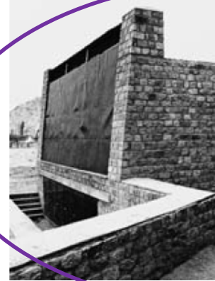
Arup Associates: Schule, Ladalch Indien 2001 (Sonnenfänger) Aus: Energie Atlas Nachhaltige Architektur Egger, Fuchs, Stark, Zeumer, 2008, Basel/Boston/Berlin S. 231
