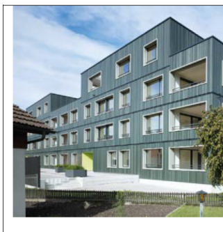
Gebäudetyp 8 Nr. 3, Baujahr 2014 Tragwerkstyp: Stützensystem Holz Wandtyp: Holzrahmen Lochfassade Deckentyp: Holzrippendecke / UB Typ Aussenraum: Loggien einzeln ➔ „Neubau hybrid“
