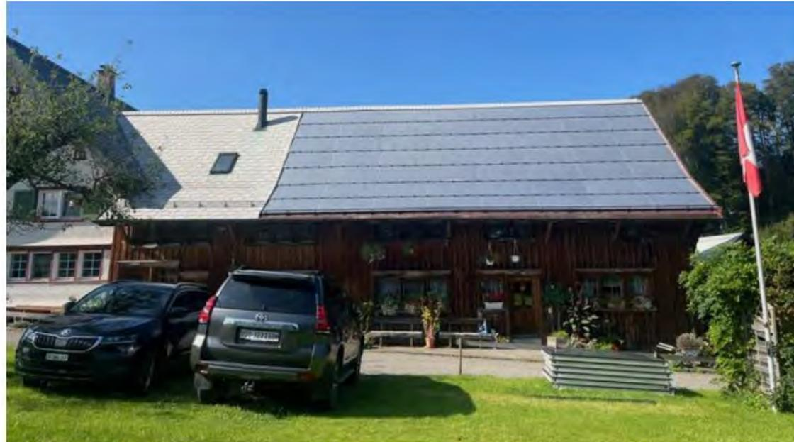
Vorteile: Die Indachanlage fügt sich nahtlos an das bestehende hellgraue Eternitdach an und nimmt die Farbe in einem dunkleren Grauton auf. Die Vollflächige Ausführung wirkt optisch zurückhaltend.
