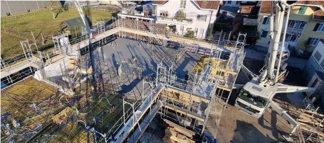
zirkulit beton® – Haus der Freunde, Buchs SG
