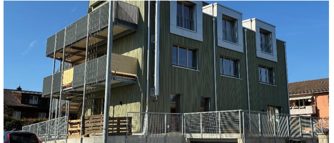
zirkulit beton® – MFH, Bremgarten b. Bern
