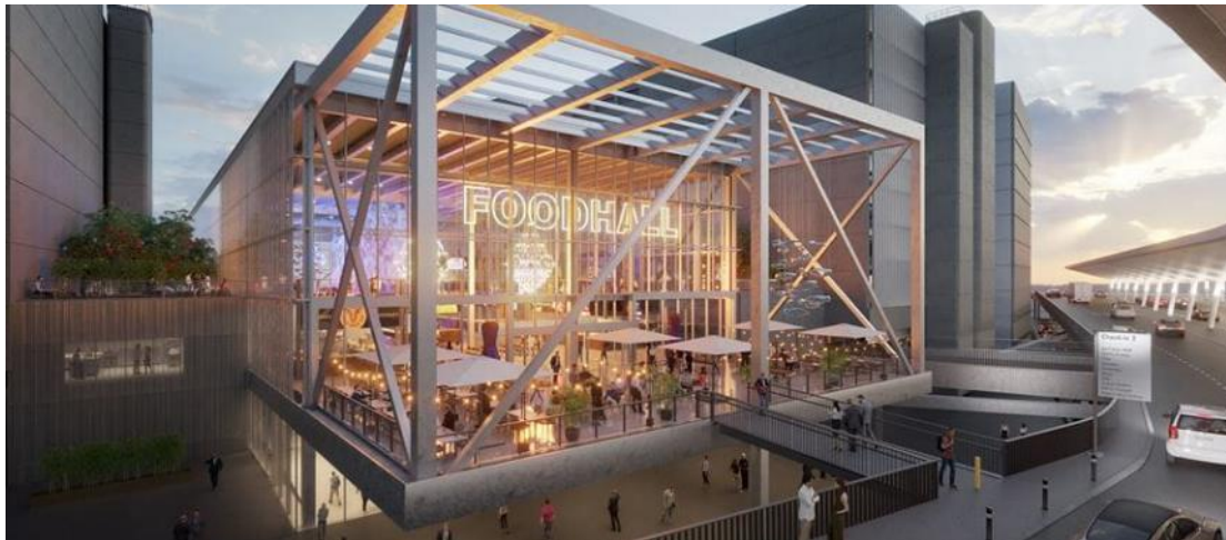
zireco beton® – ELP Flughafen Zürich
