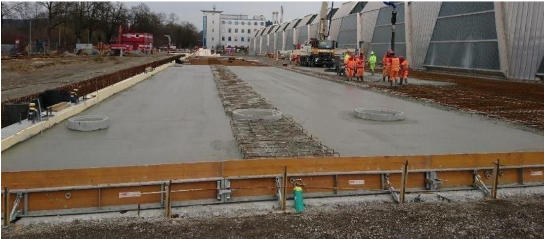
zirkulit beton® – Tramdepot Bernmobil, Bern
