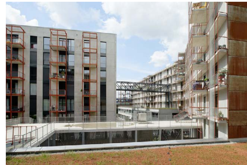
Zwicky Süd mit Kraftwerk 1
