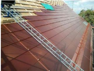
Amorphes Silizium auf Dünnschicht-Basis, laminierte Filterschicht, ca.5%
